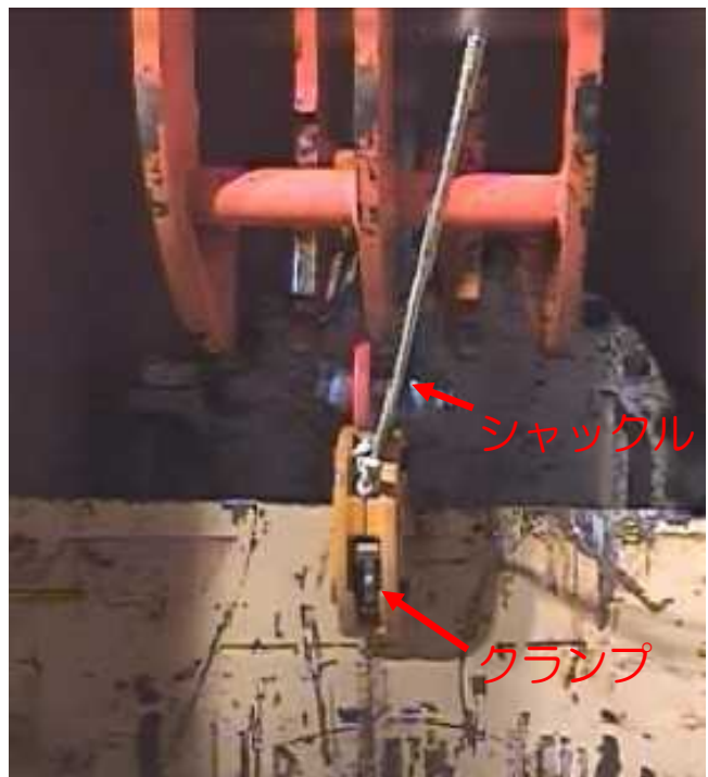
背面鉄板引抜状況
