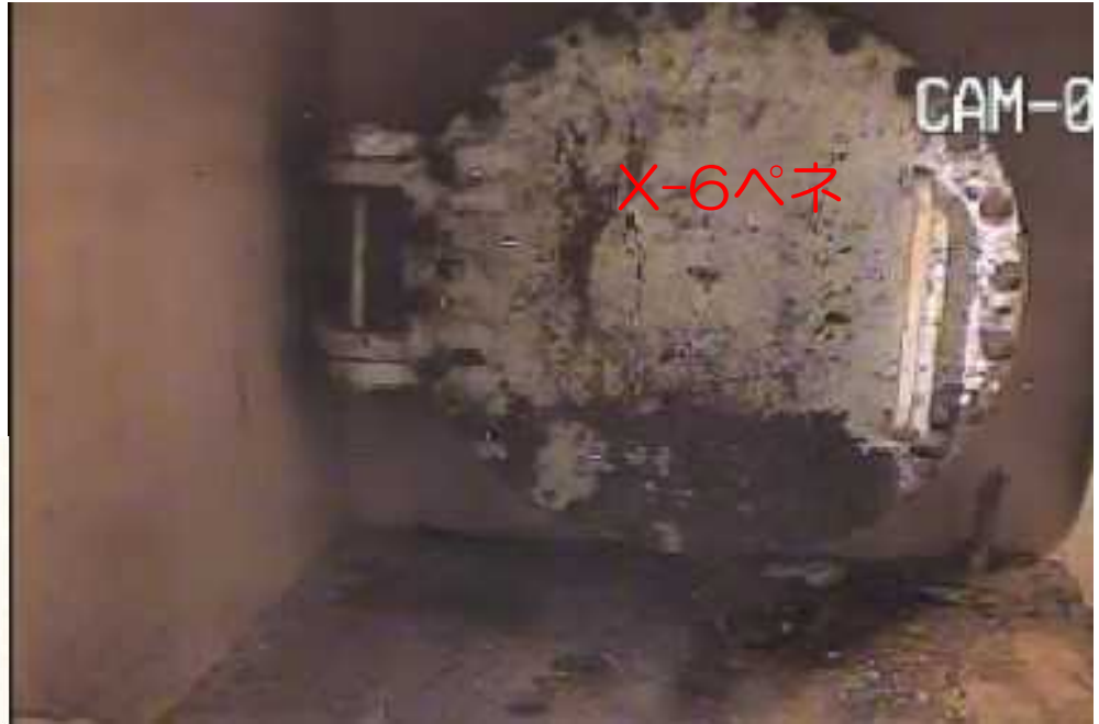
背面鉄板撤去後
