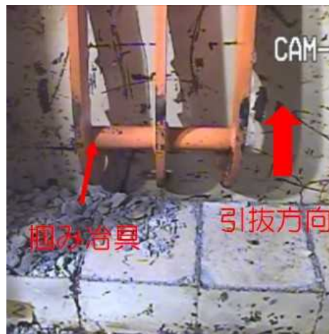
背面鉄板引抜状況
