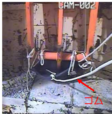
背面鉄板引抜状況
