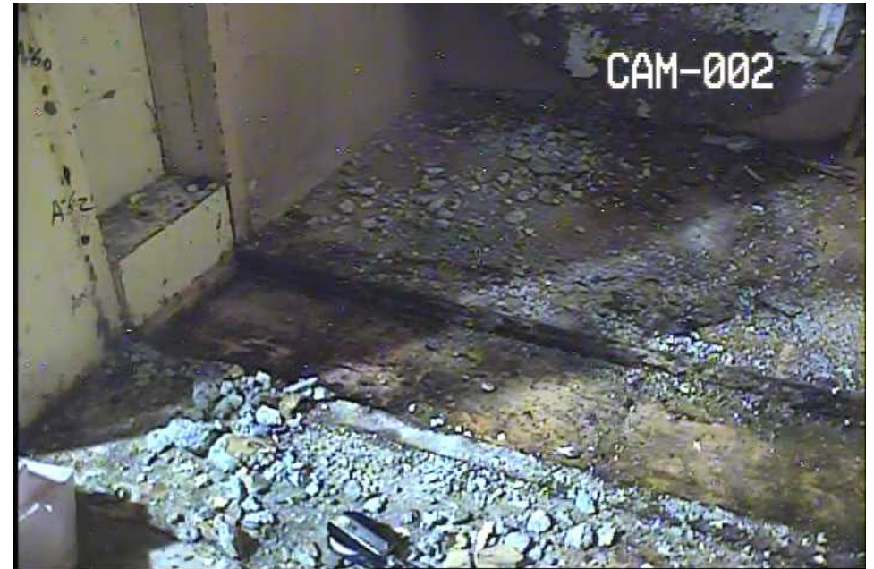
ブロック撤去後の状況
