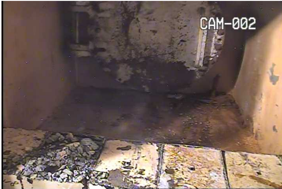
ブロック撤去前の状況
