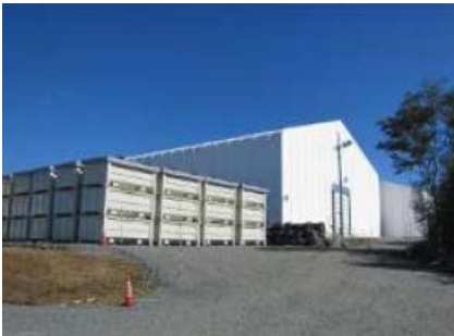
ガレキの保管エリア（テントと容器）
