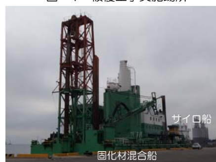
写真－1 作業船団（小名浜港にて撮影）
