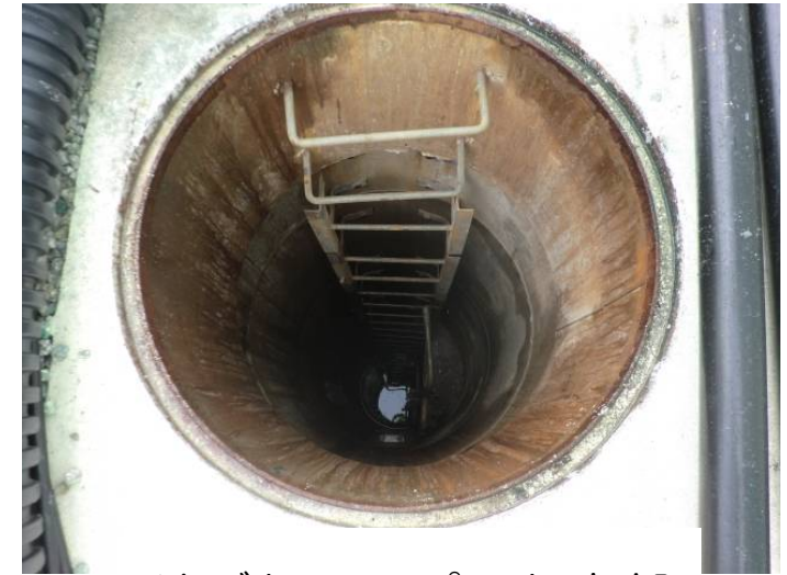
サブドレンピット内部
