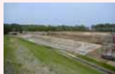
保護土工を実施中（2槽目） [2012/5/24撮影]
