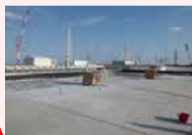
屋上コンクリート撤去状況
