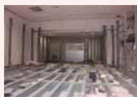
ゲートモニタ室鉄骨組状況
