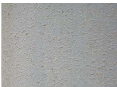
⑤ 西面（外壁）
