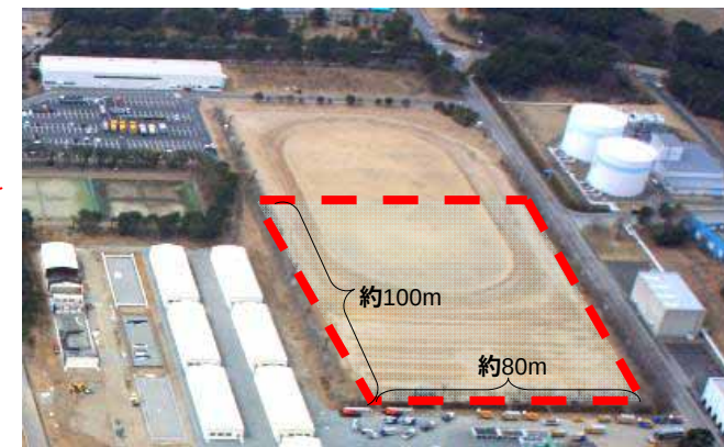
使用済燃料乾式容器仮置き場 (グラウンド内東側)
