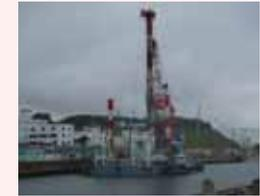
遮水壁先行削孔準備作業状況
