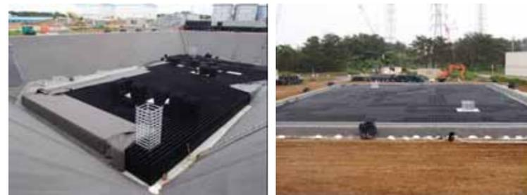
図2：地下貯水槽設置状況
