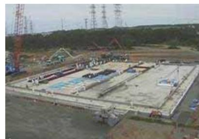
図1：多核種除去設備基礎施工状況
