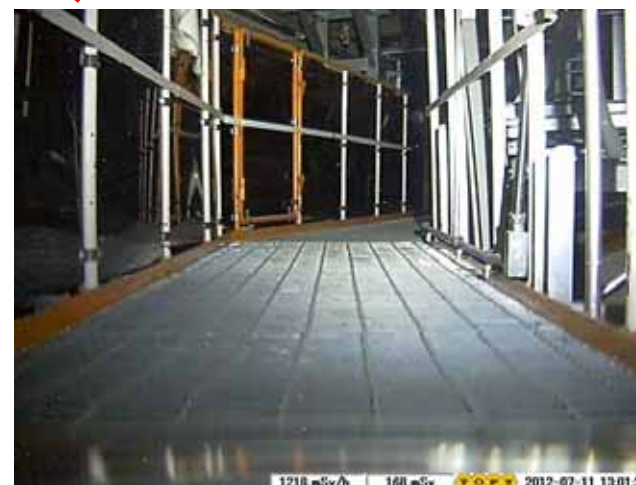
グレーチング状況
