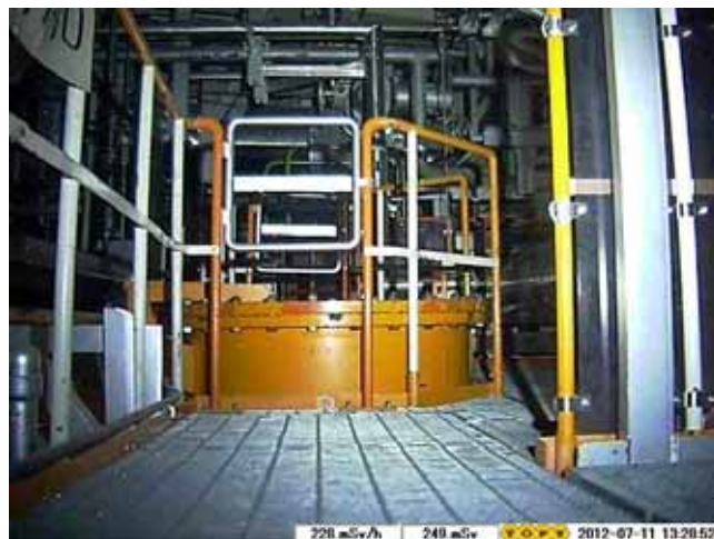
北側マンホール
