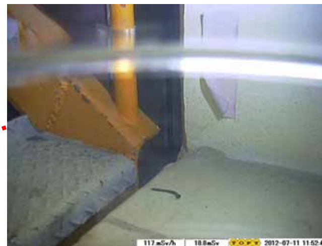
トラス室入口
