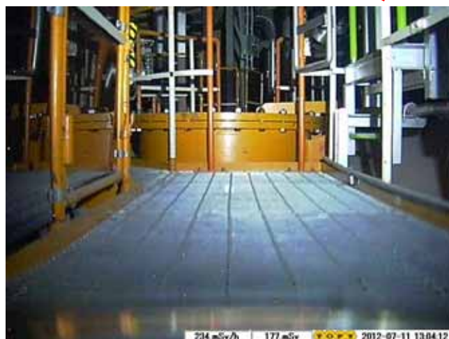
南東マンホール
