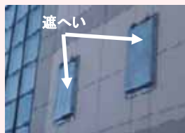
鉛材による窓部遮へい状況
