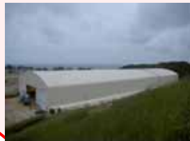
覆土式一時保管施設準備工事完了 (1 槽目：H24.6.13撮影)
