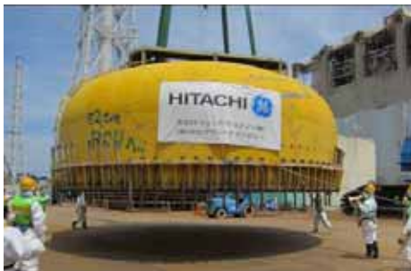
吊り降ろし作業
