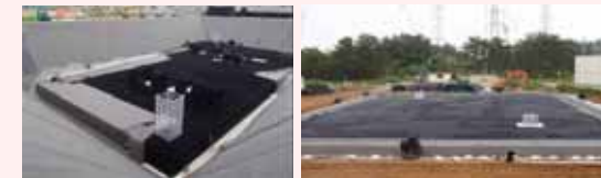
地下貯水槽設置状況
