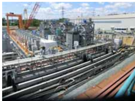
図 2：多核種除去設備機器設置の様子（8 / 1 9）
