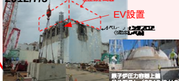
原子炉建屋上部のガレキ撤去
