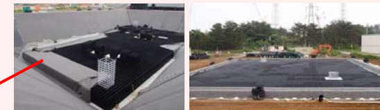
地下貯水槽設置状況
