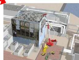
原子炉建屋上部のガレキ撤去
