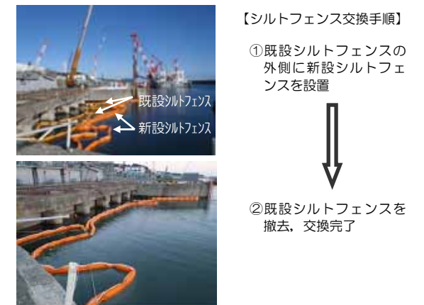
図 4：シルトフェンス交換の様子
