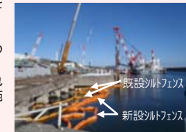
シルトフェンス交換の様子
