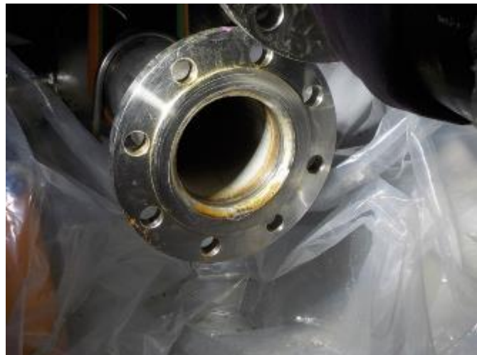
ガスケット（鋼管側面）
