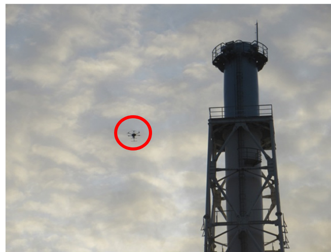
調査風景 調査用
