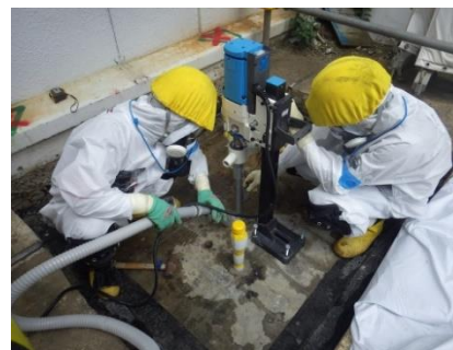
写真③ アンカー削孔
