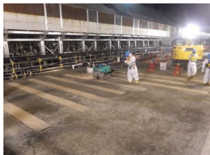
写真② 路盤整備状況
