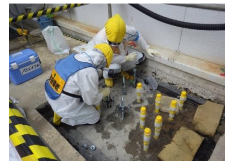
写真④ アンカー設置
