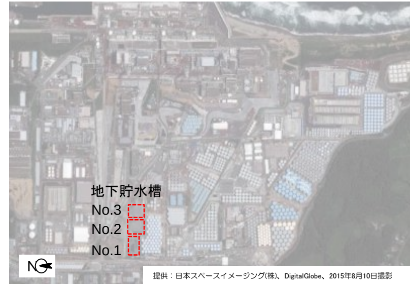
図 地下貯水槽No.1～3の位置
