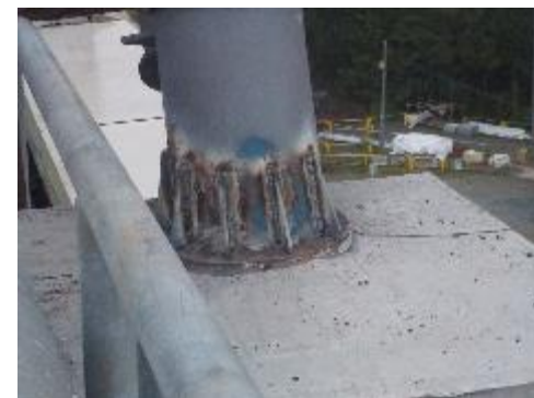
溶接による補修
