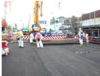
写真② 40mm鉄板敷設
