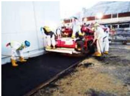
写真① アスファルト舗装
