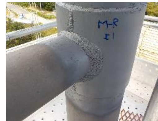
補修後（水平材）
