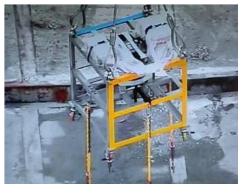
クレーンによる遠隔操作状況
