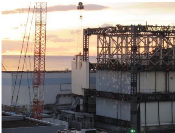
壁パネル吊り下し状況
