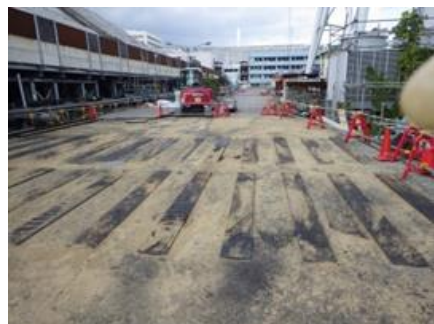
写真① 路盤碎石敷設完了
