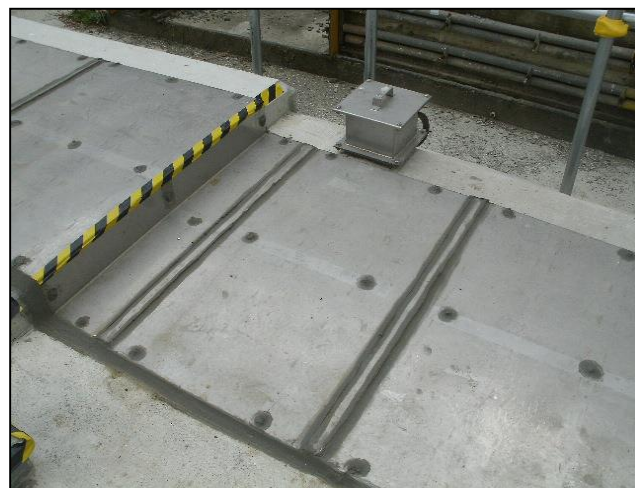
PE管施工状況＜屋外＞
