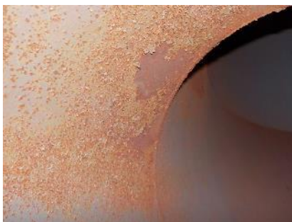
<排ガス補助ブローA入口側煙道>
