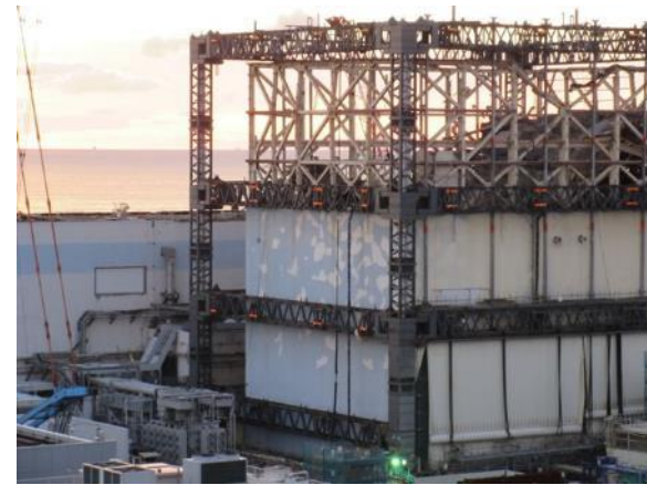
取り外し後建屋状況
