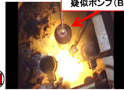
疑似ポンプ (B) 投入作業状況
