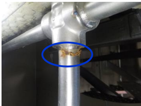
＜排ガスブロアA逆止弁ドレン配管＞
