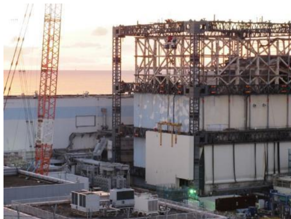
壁パネル吊り上げ前状況
