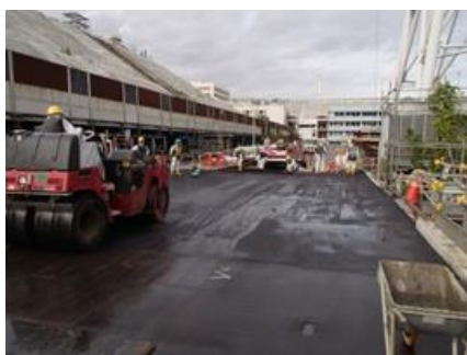
写真② アスファルト舗装中
