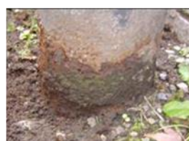
金属柱地際腐食（例）
