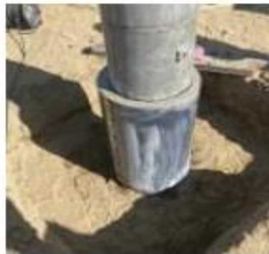
延命化工法（地際補強）
