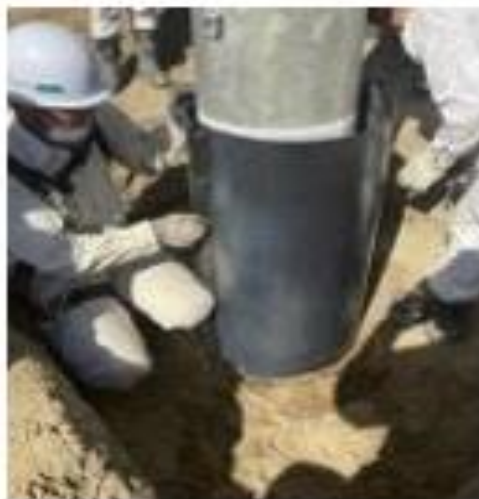
延命化工法（地際補強）
