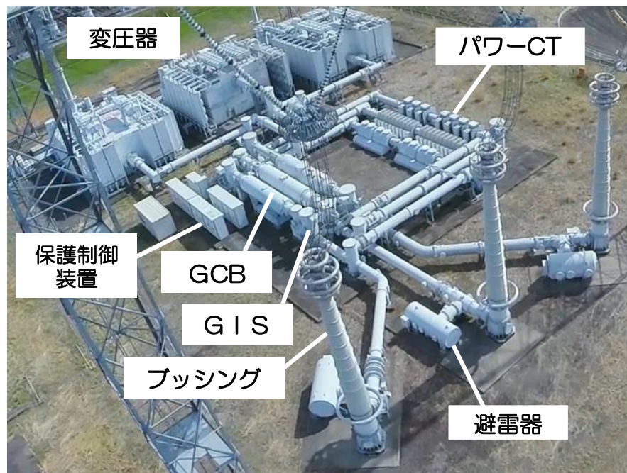
UHV機器試験場 実証試験設備の構成 [新榛名変電所構内(群馬県吾妻郡)]
