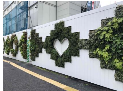
工事中の仮囲い緑化
