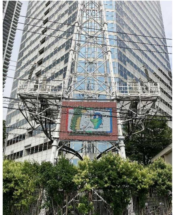
なお、今回のデジタルサイネージではシースルービジョンを採用することで、装置の風による鉄塔への負荷を抑制し、十分な安全性を確保したうえで広告を実施いたします。
