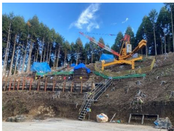
鉄塔基礎 施工後 2024年12月7日撮影
