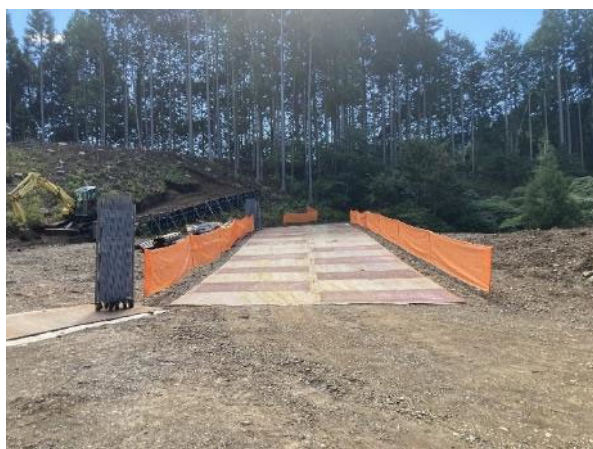
仮設道路 施工後 2024年9月21日撮影
