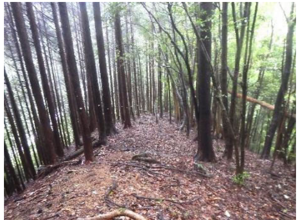
鉄塔 No. 36 工事用地の環境
