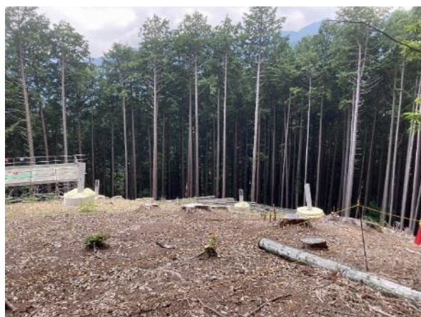
鉄塔基礎 施工後 2024年7月26日撮影
