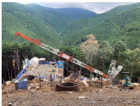
鉄塔基礎 施工中 2024年9月13日撮影
