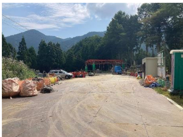
索道基地 施工後 2024年8月9日撮影
