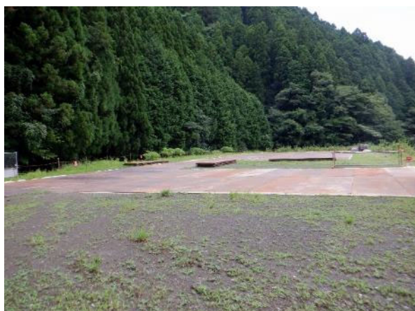
モノレール基地 施工後 2023年8月7日撮影
