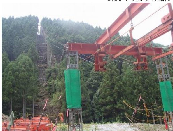
索道 施工後 2024年7月18日撮影
