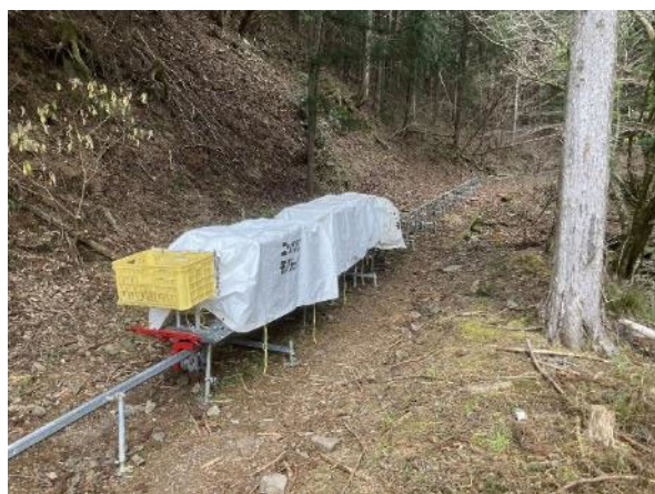
モノレール 施工後 2024年7月16日撮影
