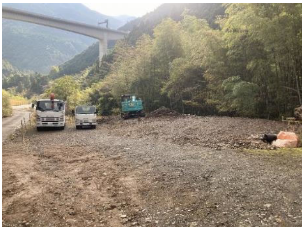
残土処理場 施工中 2024 年 11 月 12 日撮影
