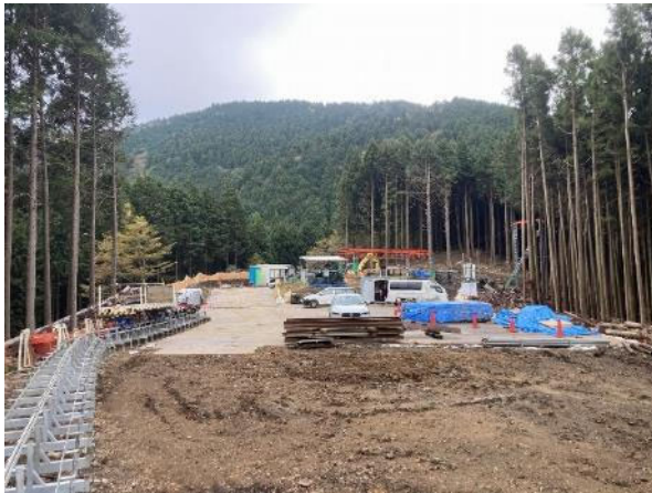
モノレール基地等 施工後 2024年11月12日撮影
