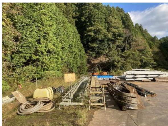
モノレール 施工後 2024年11月12日撮影
