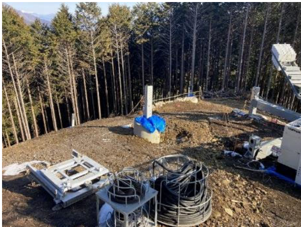
鉄塔基礎 施工後 2024年12月10日撮影
