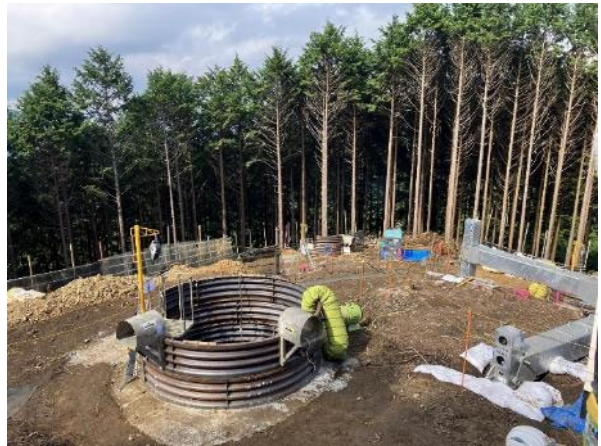
鉄塔基礎 施工中 2024年9月18日撮影
