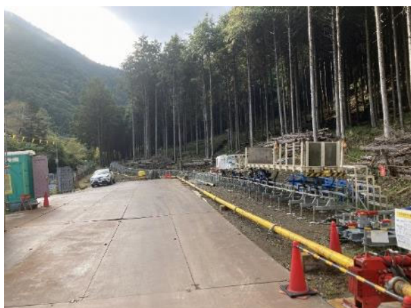
モノレール基地及びモノレール 施工後 2024年11月12日撮影
