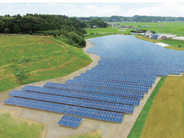
メガソーラー発電所建設
