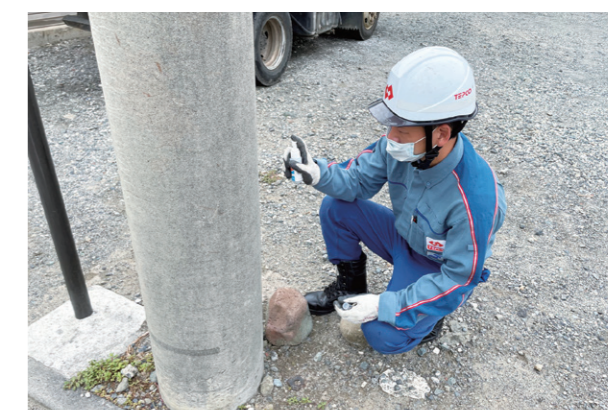
鉄筋コンクリート柱診断風景
