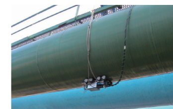
水管橋板厚測定
