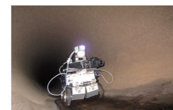
水圧管内部点検
