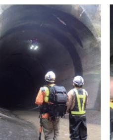
ドローンによる水路トンネル診断
