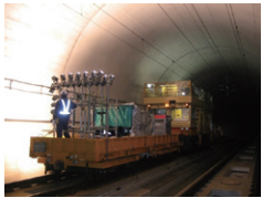
鉄道トンネル
