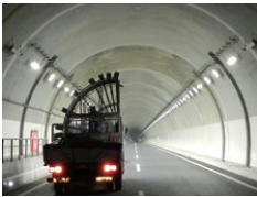
道路トンネル
