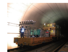
鉄道トンネル
