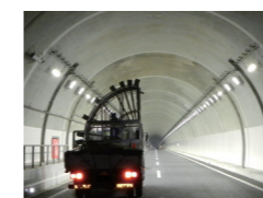
道路トンネル
