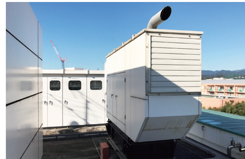
非常用発電機の屋上設置例
