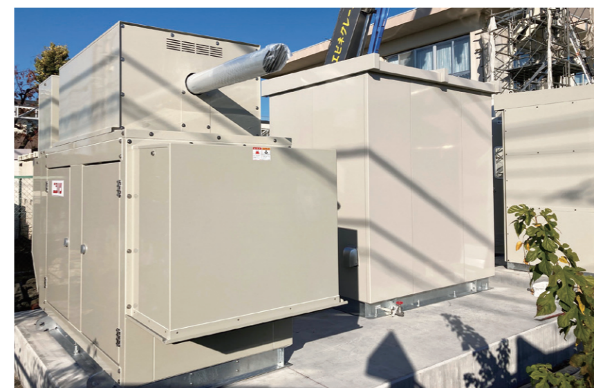
非常用発電機・燃料タンク
