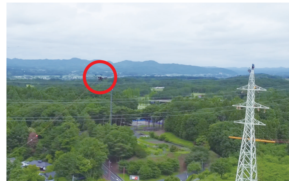
ドローンを活用した 工事・保守の様子
