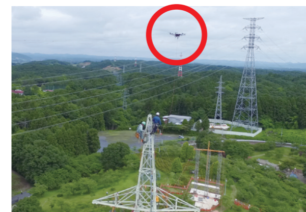
ロープ延線状況
