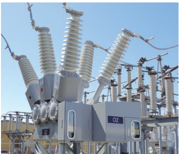
72/84kV タンク形ガス遮断器
