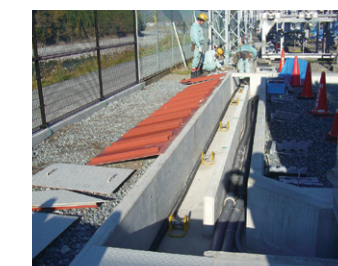
ケーブル敷設工事
