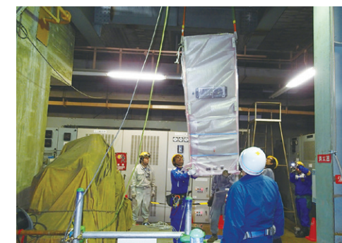
発電機盤他更新工事
