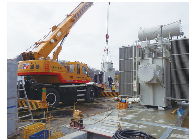
特高変電所新設工事
