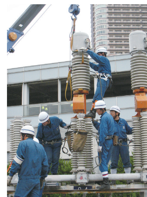
特高変電所更新工事
