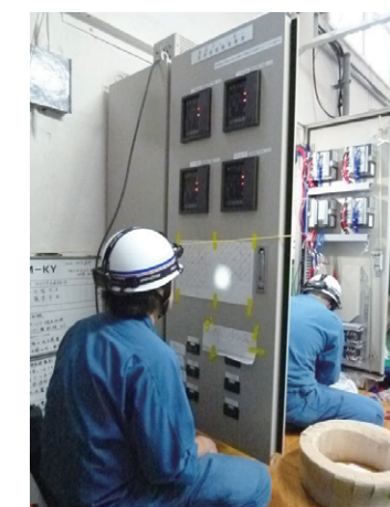
キュービクル更新工事
