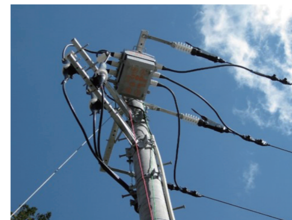
25年を経過した高圧受電設備の更新
