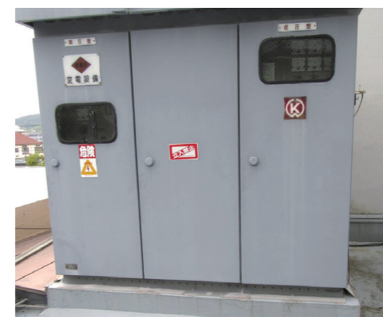
老朽化した屋外キュービクル
