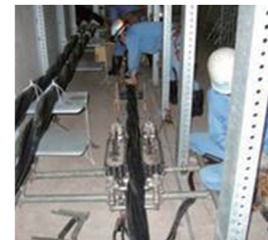
地中ケーブル新設工事
