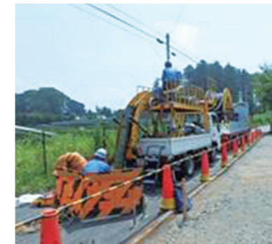
地中ケーブル新設工事
