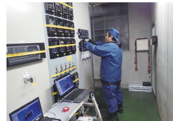
保護リレー取替工事
