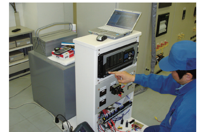
仮設保護制御盤設置工事
