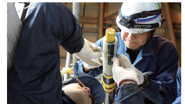
ケーブル外導処理
