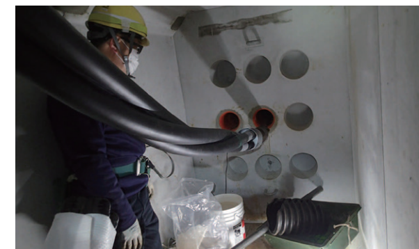
ケーブル引入作業(マンホール内)
