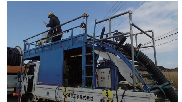
ケーブル引入作業
