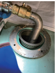
潤滑油の注油作業
