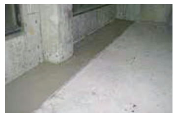
ヒートブリッジ(熱橋)部分の 断熱に使用
