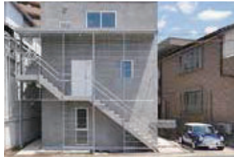
カルダンウォール高断熱を使った 外断熱工法 1
