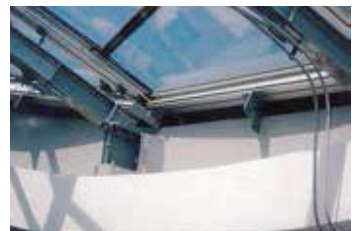
天窗周囲コンクリートの断熱
