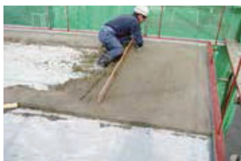
屋上の防水下地に使用（鉄骨造）
