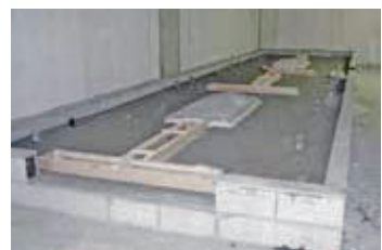
商業施設の厨房床の軽量化
