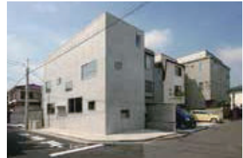
カルダンウォール高断熱を使った 外断熱工法 2
