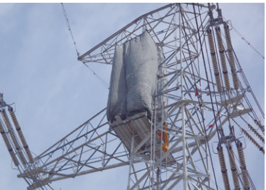
施工状況(ブース外)
