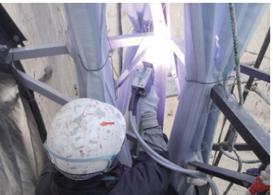
施工状況(ブース内)
