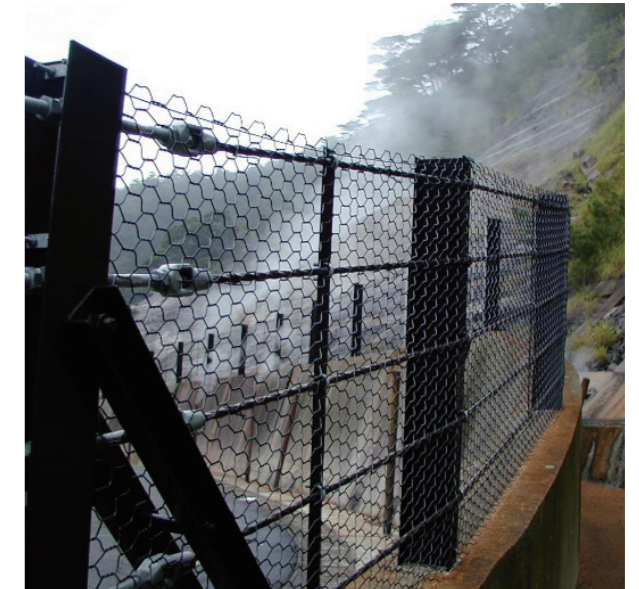
火山性ガス発生地帯の落石防止柵「ストーンガード」
