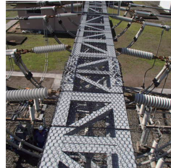
変電所ガントリーの営巣対策「防鳥ネット」
