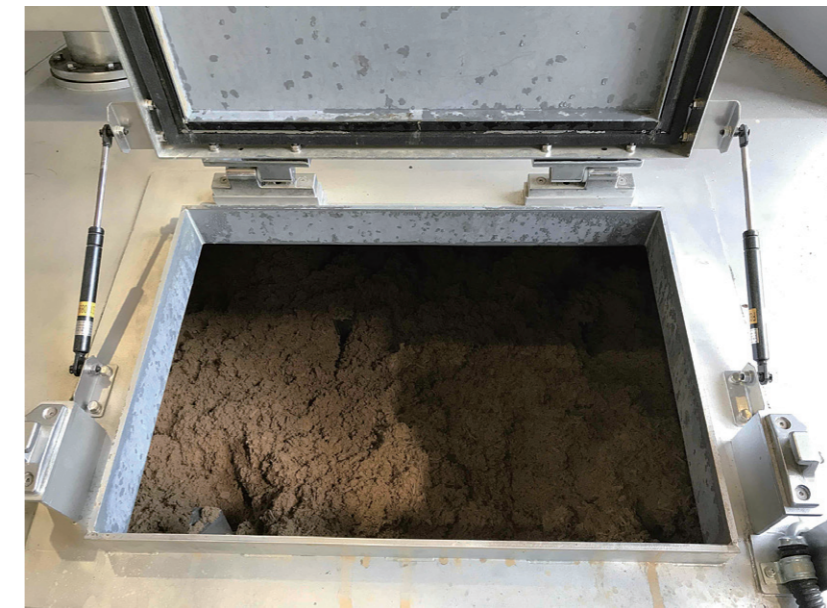
処理槽内部の様子
