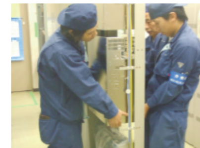
屋内／機器新設作業
