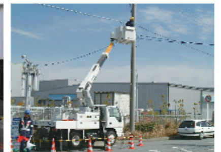
高所作業／高所作業車使用
