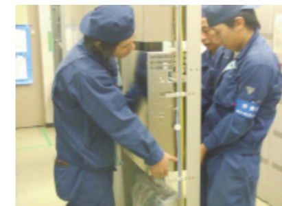
屋内／機器新設作業
