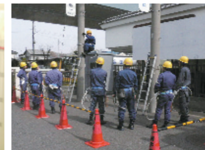
配電柱／昇柱訓練
