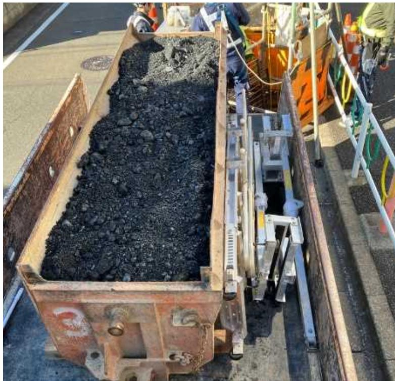
路面変位の**自動計測機器**の設置完了
