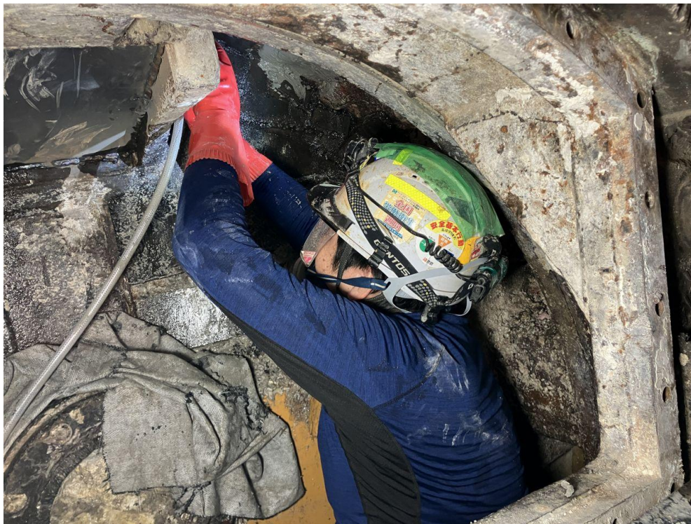
シールドマシン先端部での作業状況
