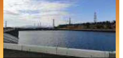
淡水貯水池設置
