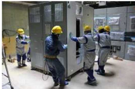
1号機 電源盤 (P/C 1C-1) 据付作業
