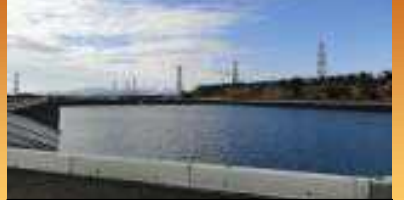
淡水貯水池設置
