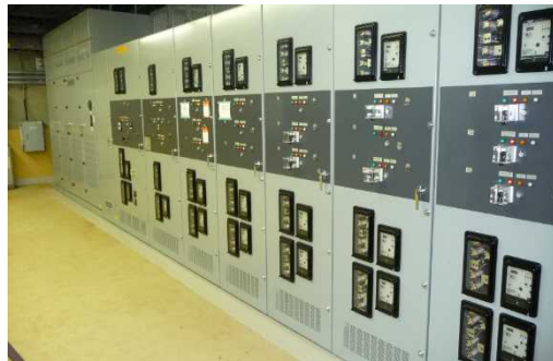
1号機 電源盤(P/C 1G-1)据付後
