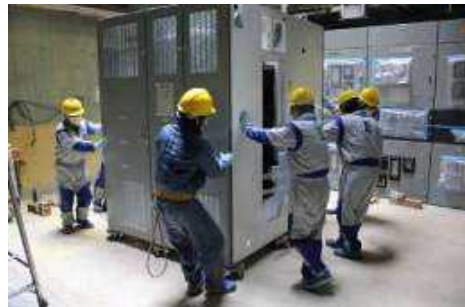
1号機 電源盤(P/C 1G-1)据付作業
