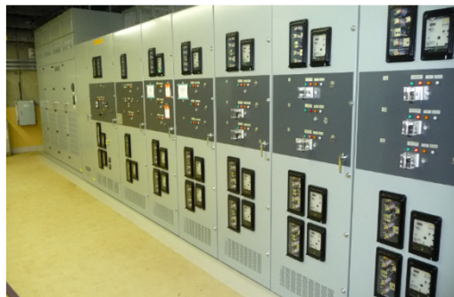
1号機 電源盤(P/C 1G-1)据付後
