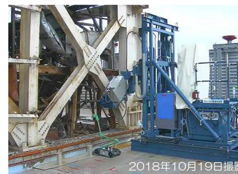
Xブレース撤去の状況写真（南面）
