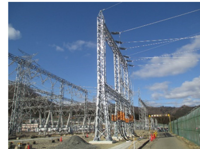
新福島変電所
