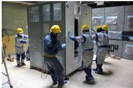
1号機 電源盤(P/C 1G-1)据付作業
