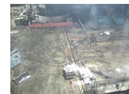
② 残置物片付け後（北側） 撮影日(10/22)
