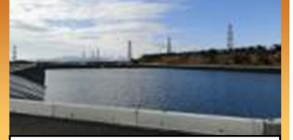
淡水貯水池設置
