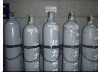
予備ポンベの配備
