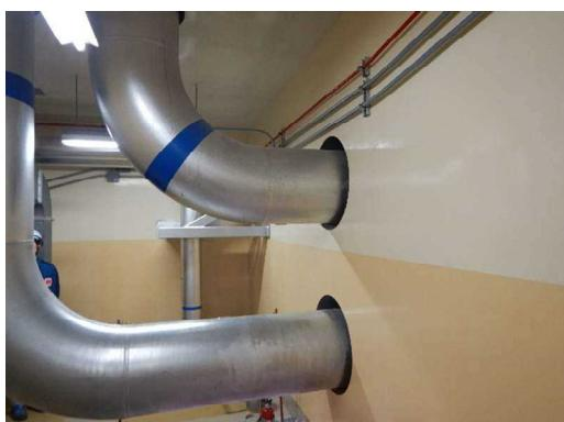
図3. 貫通孔の隙間の例
