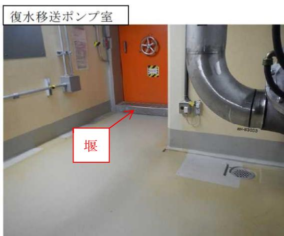
第 1・2 図：堰による拡大防止対策概要図
