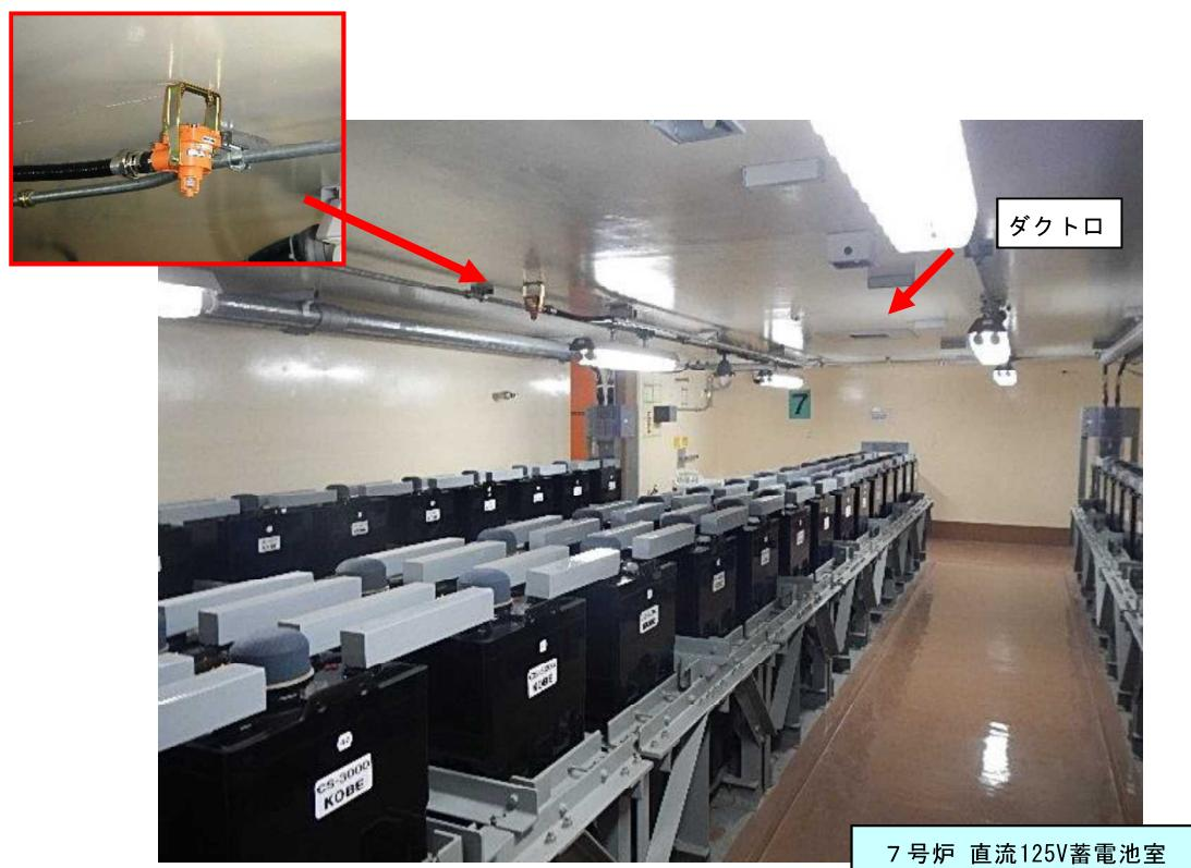
第 1-7 図：蓄電池室内の水素濃度検出器設置状況
