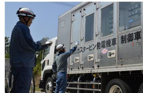
空冷式ガスタービン発電機車起動訓練
